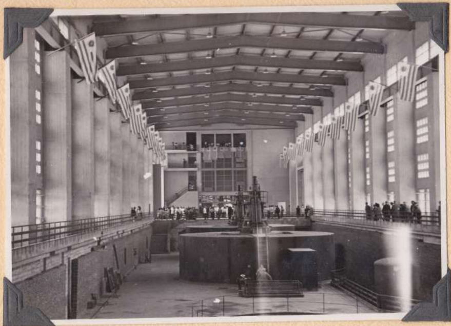
Vista general de la sala de máquinas tomada desde el lado este.
